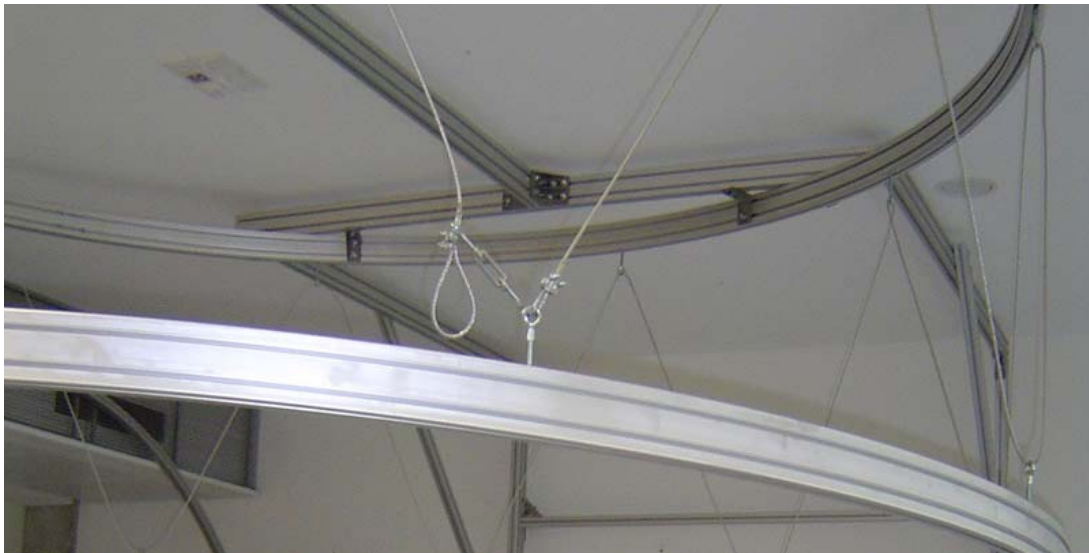
Bild 4) Aufhängung des oberen Zylinderrings am Trägerring
