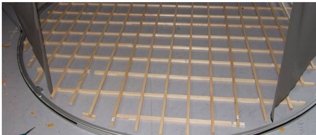
Bild 5) Gitterstruktur aus Kanthölzern unter den Bodenplatten
